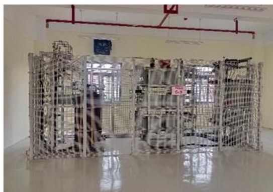
图4：孟加拉达卡地区电网系统扩容和升级项目
