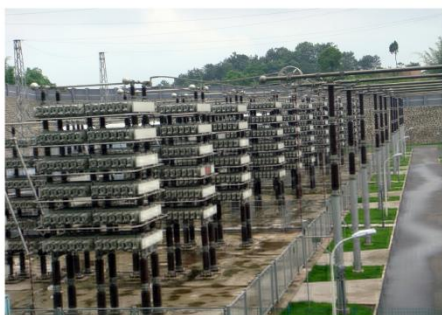
图8: 桂林电容特高压运行案例（向家坝-上海±800kV 特高压直流输电工程）
