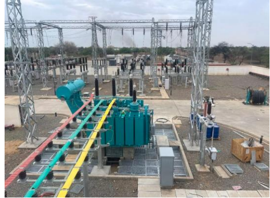
图34: 乍得项目: SZ11-2500090 变压器
