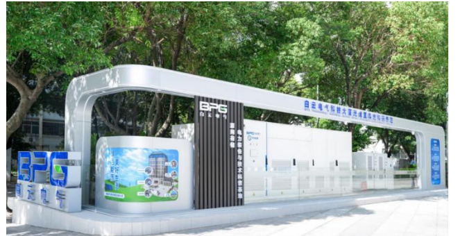
图25: 智能楼宇光储柔直充示范工程
