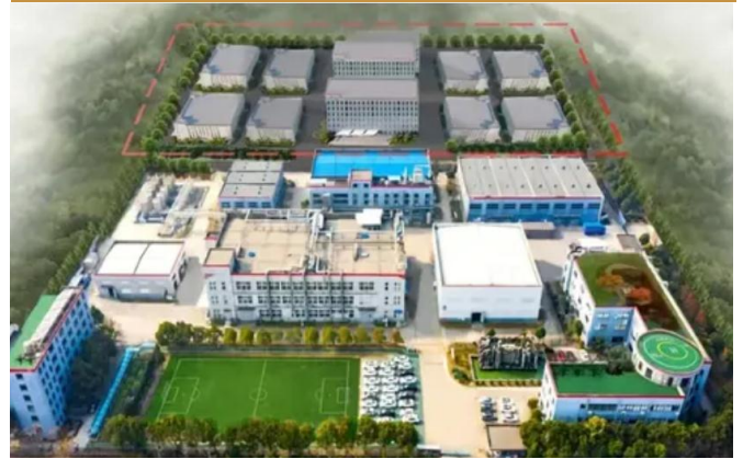
图 10：公司“万吨水性环保汽车涂料”项目生产厂房
